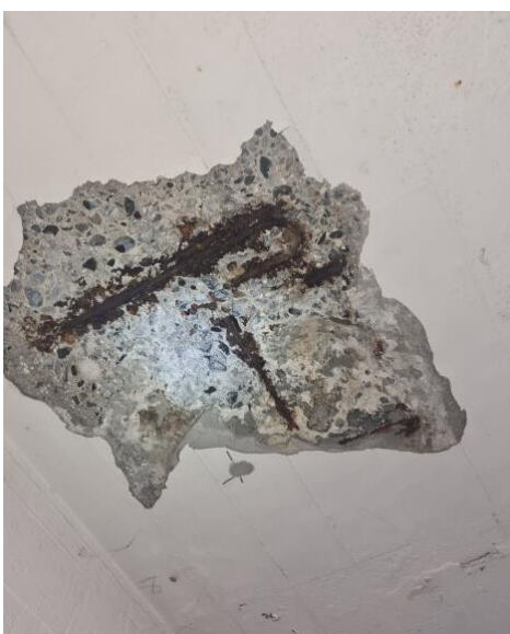
Blotlagt skade på dæk over 1.sal. Tilstand: K2 – tidligere vurderet K1
