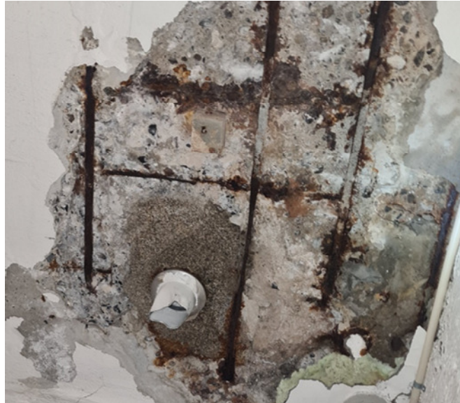
04/ Samme sted, efter ophug. Tilstand K3. Armerings tværsnit reduceret kraftigt.
