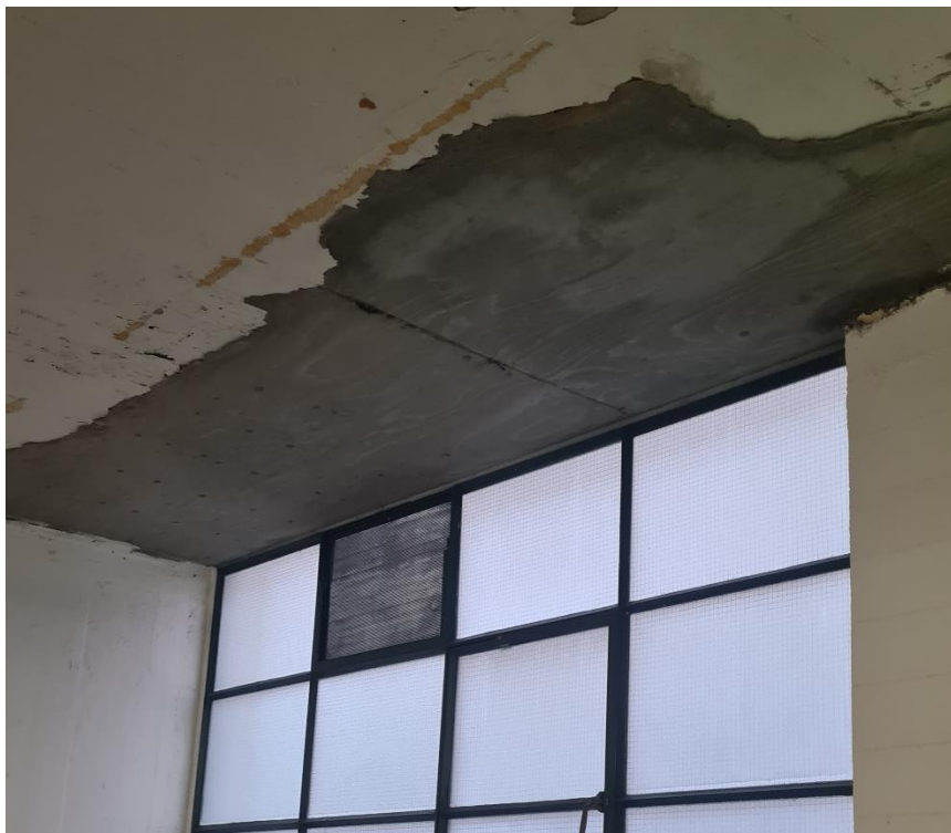
Udført reparation ved vindue.
