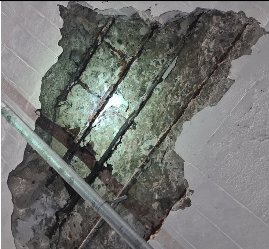
07/ Skade på loft, tilstand K3. Armeringen skrumper flere steder. 3. sal
