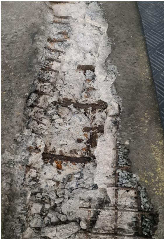
01/ Skade på gulv i stuen Tilstand K2
