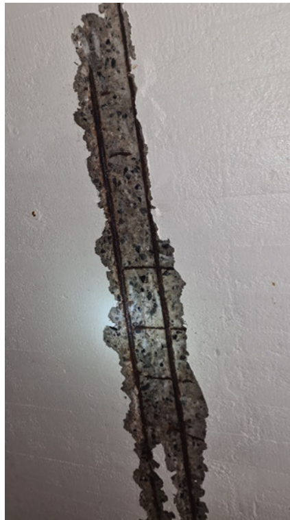
06/ Samme sted, efter ophug Tilstand K1. Rust vurderes overfladisk.
