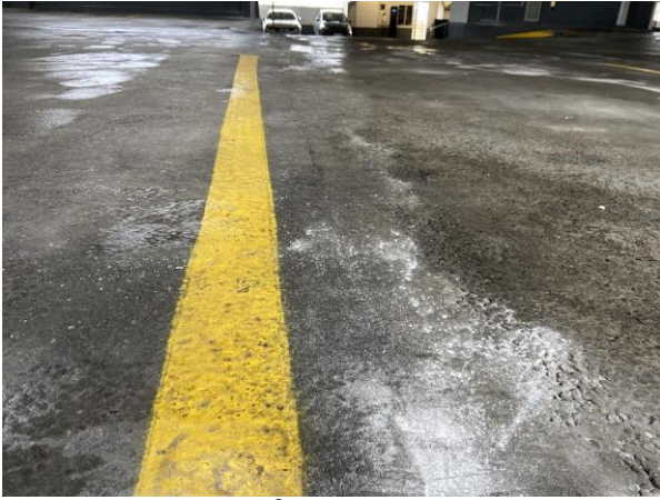
#6 Beton-samling på dæk 4, ingen revne.
