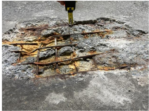
#9 Hul på dæk 4, tæt på beton-samling. Klaplag ca. 10mm.
