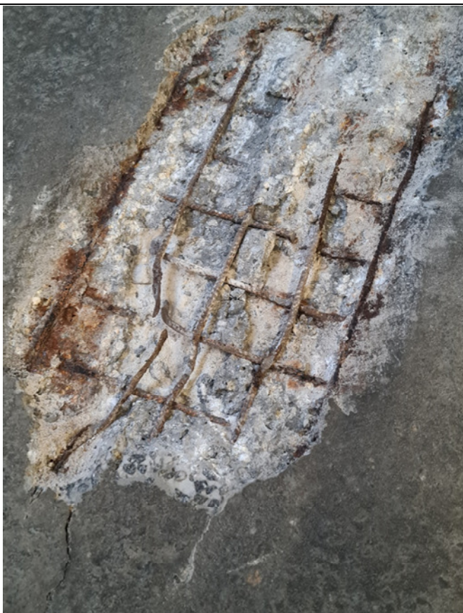
10/ Det samme, efter ophug. Tilstand K1. Netarmering hører til i slidlaget.
