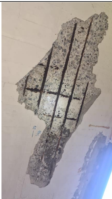
Blotlagt skade på dæk over 4. sal. Tilstand: K2 – tidligere vurderet K1
