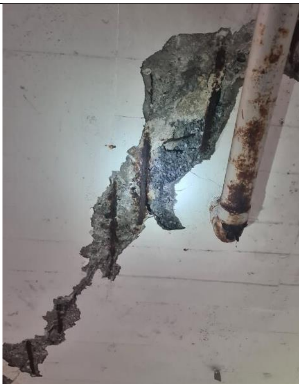
Blotlagt rusten armering på dæk over 2. sal. Mange skader observeret tæt på nedløb/faldstammer. Tilstand: K2
