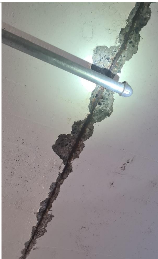
Blotlagt armeringstænger på dæk over 1.sal. Armeringsstængerne ser rustne ud. Dette kan skyldes fugt fra nedløbsrør. Tilstand: K2 – tidligere vurderet K1
