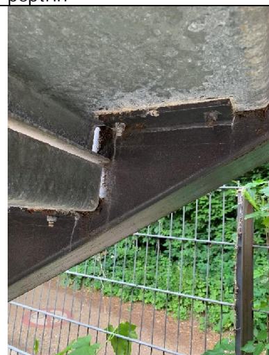
Foto 5: Montering af trappetrin
