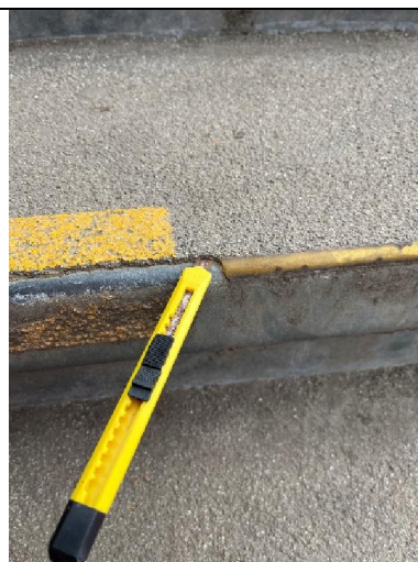
Foto 6: Kunststofbelægning slipper på trappetrin
