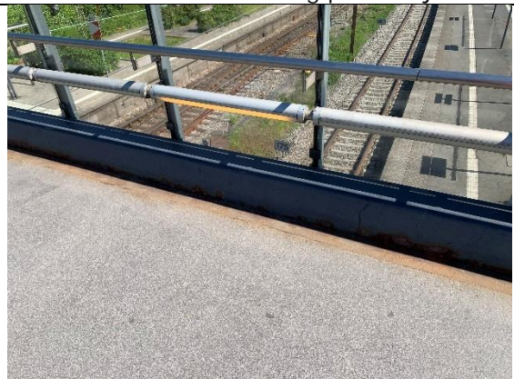
Foto 6: Kunststofbelægning mod kantbjælke
