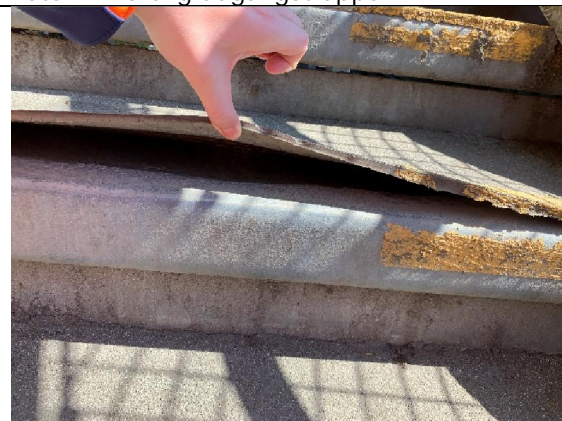
Foto 3: Kunststofbelægning slipper på trappetrin
