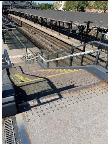
Foto 2: Opmærksomhedsfelter foran trapper
