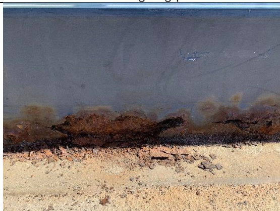
Foto 5: Overfladebehandling på kantbjælken
