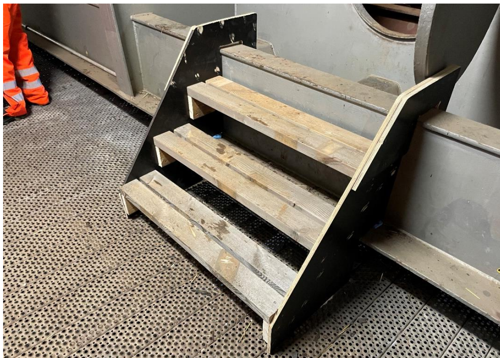
Figur 6. Billede af adgangsdør i landfæste FF00, hvor der er etableret trappe. Det er det eneste sted hvor der er etableret en trappe.
