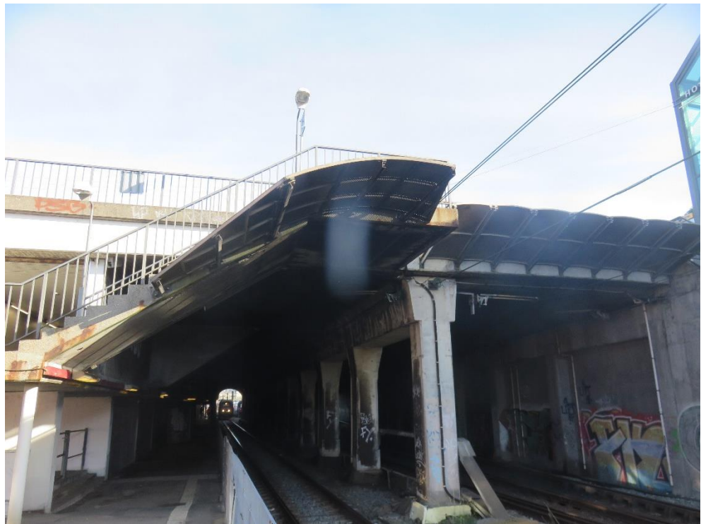
Figur 20: Eksisterende skærmstage på trappedel der fjernes og bortskaffes
