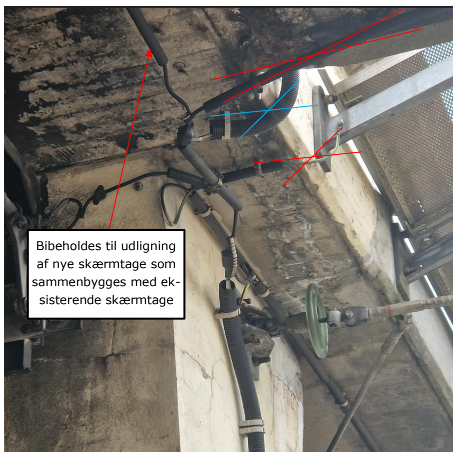
Figur 15 Skitse for fremtidigt set up af udligninger
