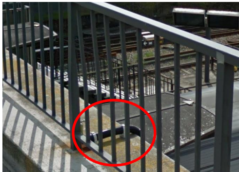
Figur 19 Udligning til sammenbundet rækværk efter lukning af dette ved spor 12
