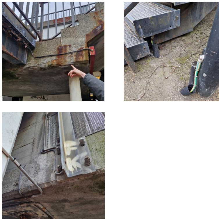
Figur 7 Apteringer der er udlignet igennem trappen (lysskinne, lysmast og afskærmning)
