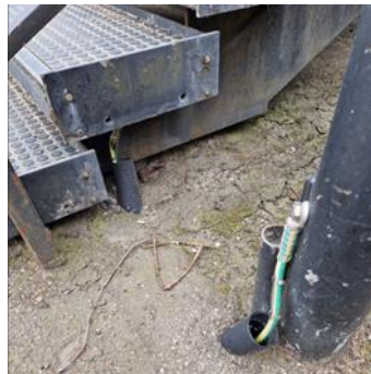
Figur 9 Eksisterende føringsrør fra lysmast til trappe
