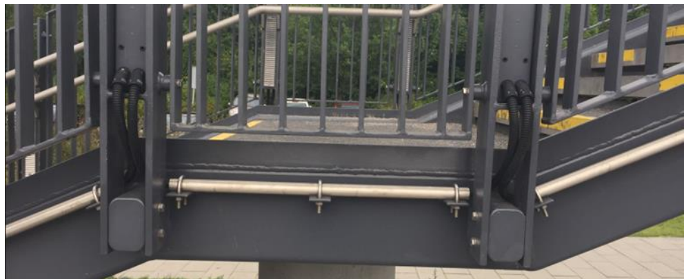
Figur 10 Etablering af rør på trappe, eksemplet er fra Tølløse station
