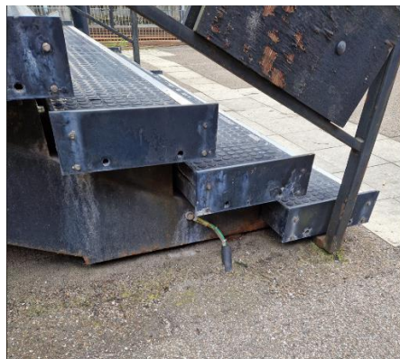
Figur 6 Eksisterende jording 2-B3-2-1 på trappe
