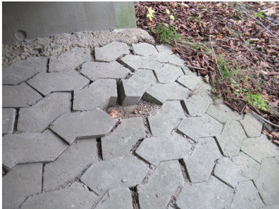
Foto 5: Skråninger: Løs skråningssikring i nord
