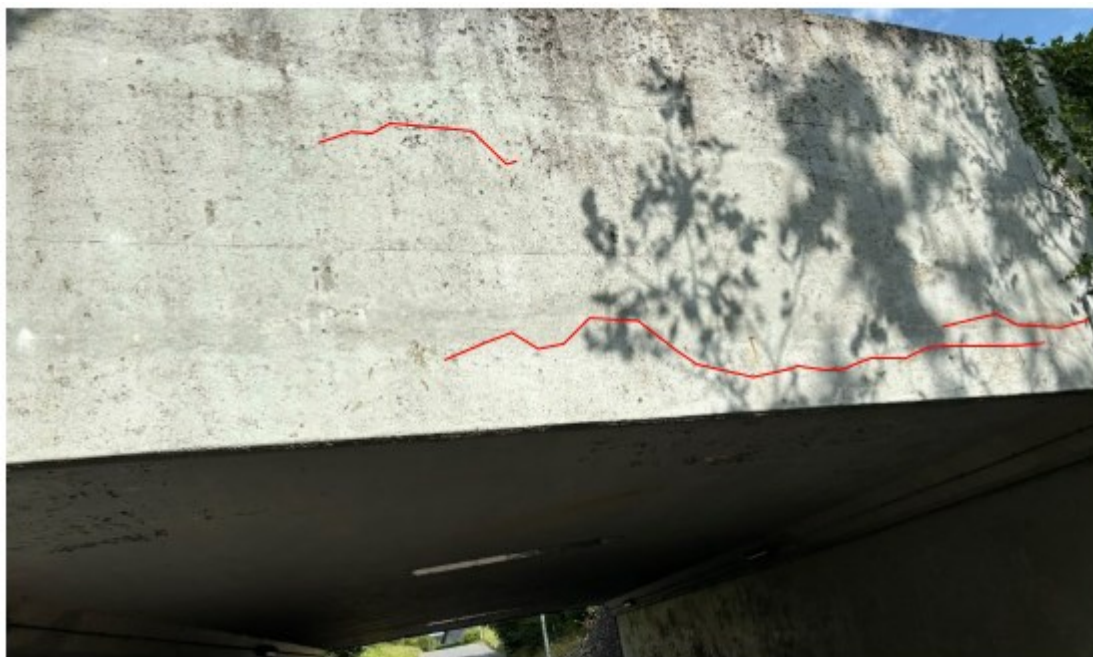
Figur 5 - Revner injiceres ved facader og fløje
