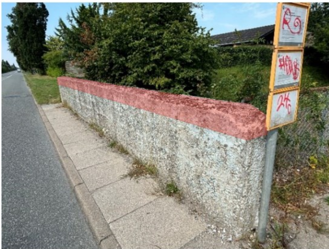
Figur 1 – Toppen af brystningsvægge i hele længden behugges og efterfølgende genopstøbes i begge sider
