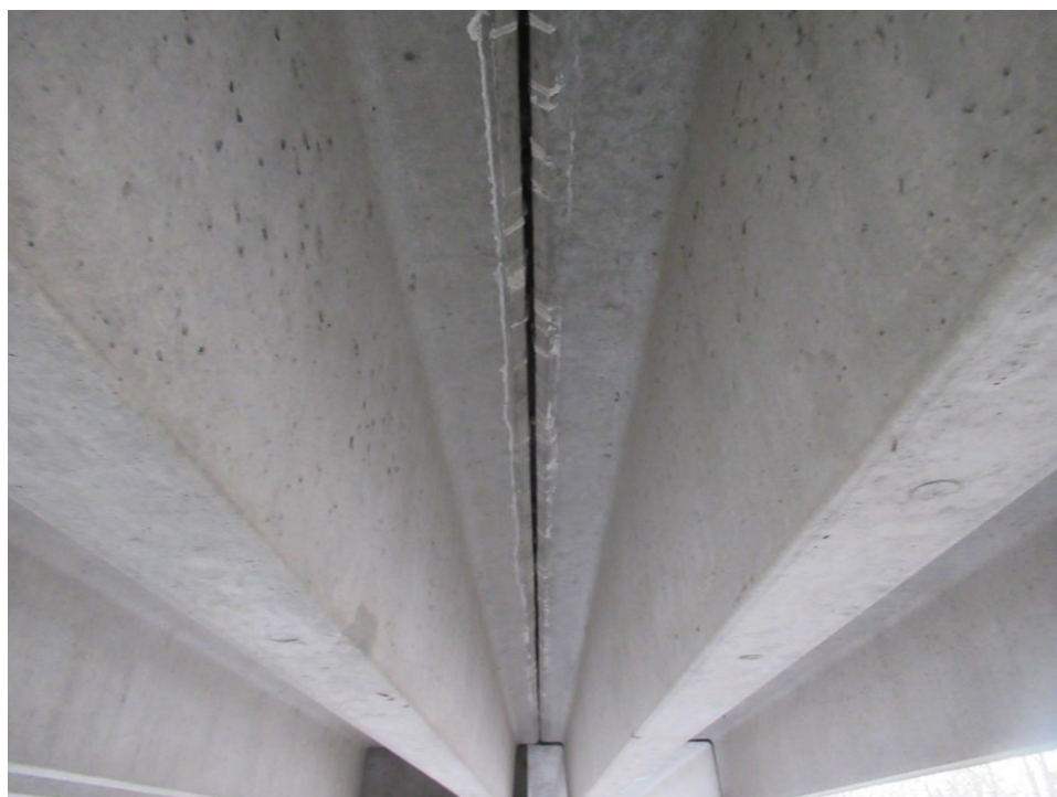
Foto 16: Bærende overbygning: Hvide udfældninger ved langsgående elementfuge
