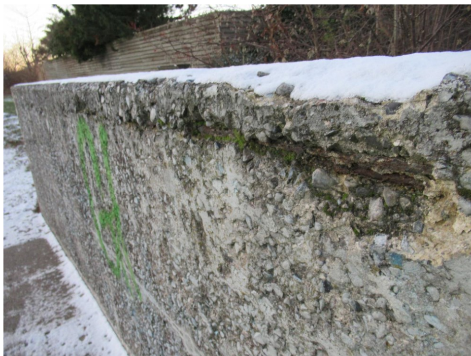
Foto 14: Kantbjælker: Betonskade med synlig armering
