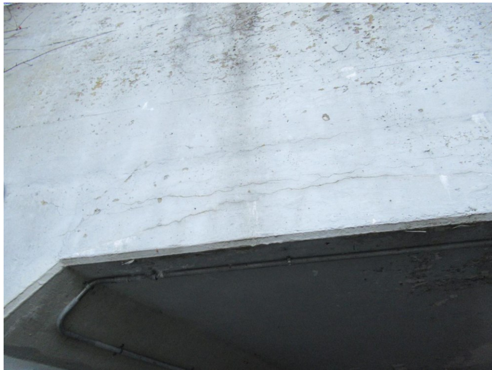
Foto 9: Bærende overbygning: Fine netrevner - enkelte hvide udfældninger
