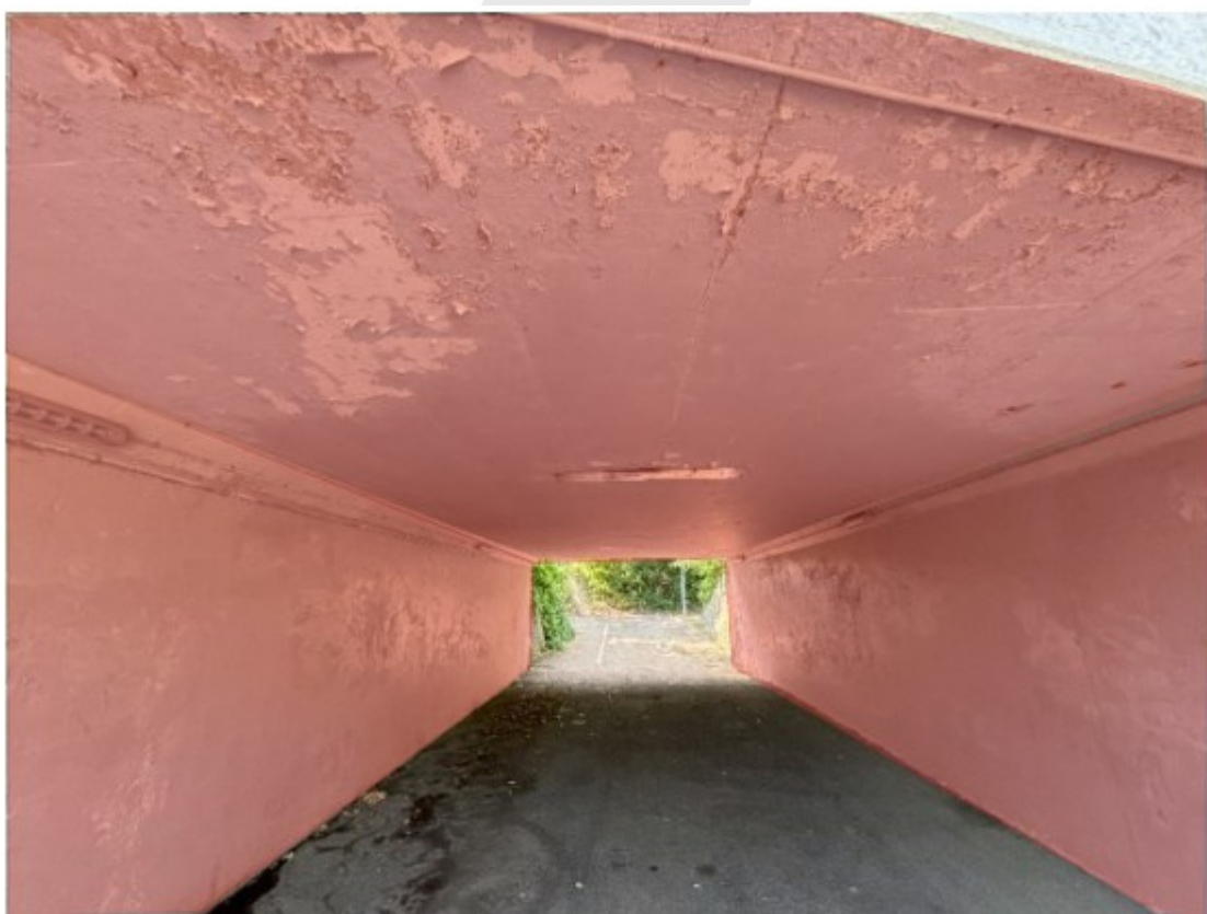
Figur 4 - Afrensning og overfladebehandling af endeunderstøtninger og US brodæk
