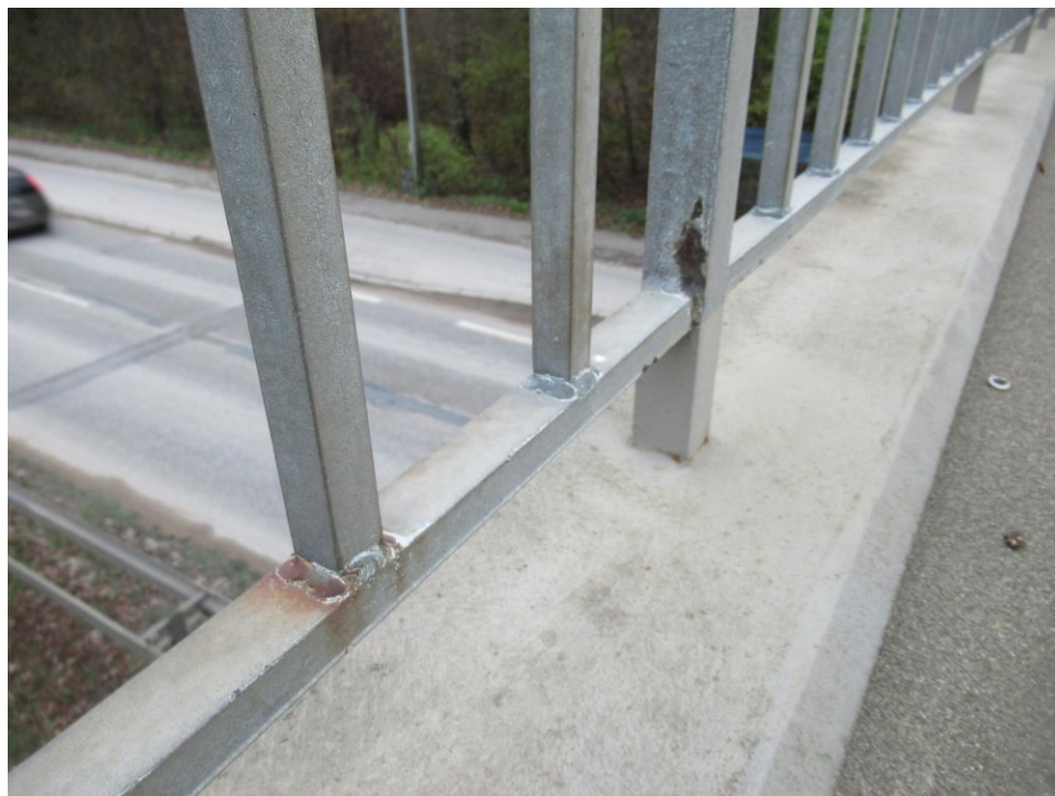
Foto 17: Rækværk: Pletvis overfladekorrosion og skader
