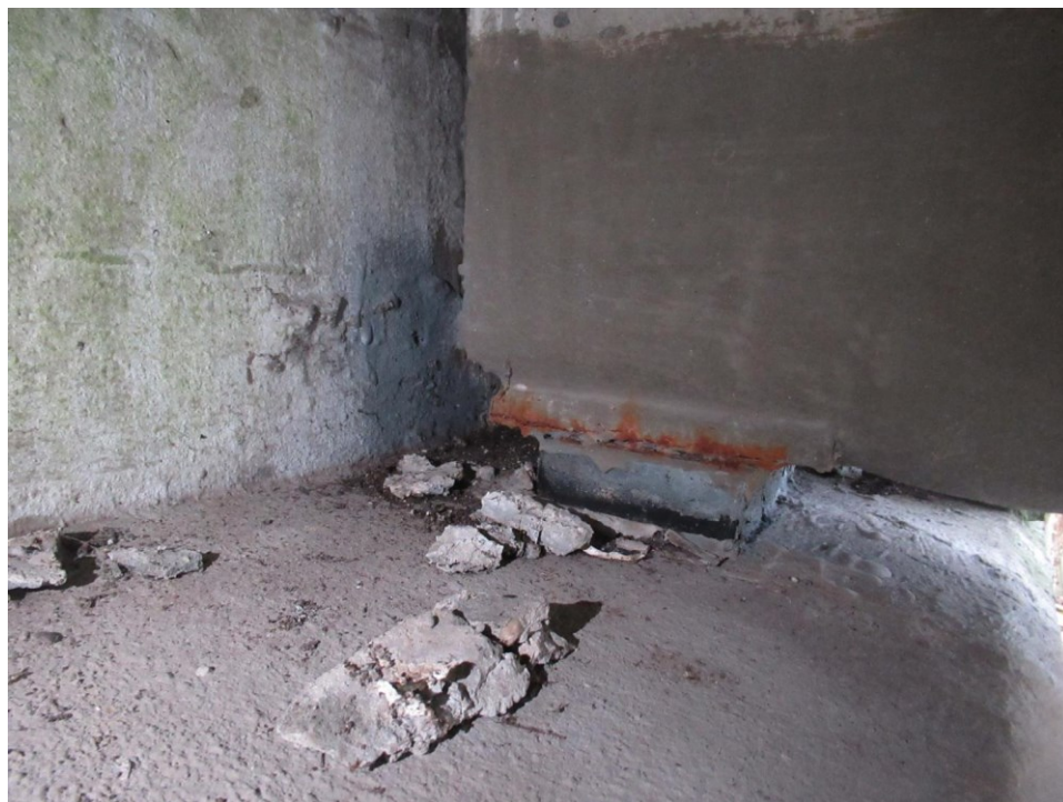
Foto 11: Lejer: Overfladekorrosion på vederlagsplader
