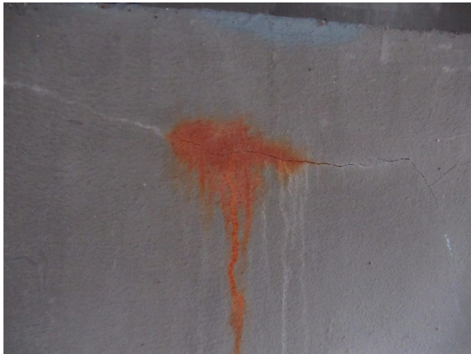
Foto 7: Endeunderstøtninger: Revne med brun udfældning - nord
