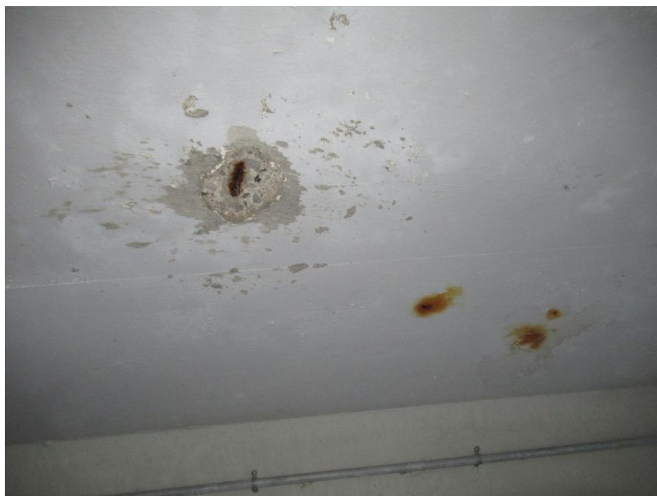
Foto 10: Bærende overbygning: Dæklagsskade med synlig armering samt rustudfældninger
