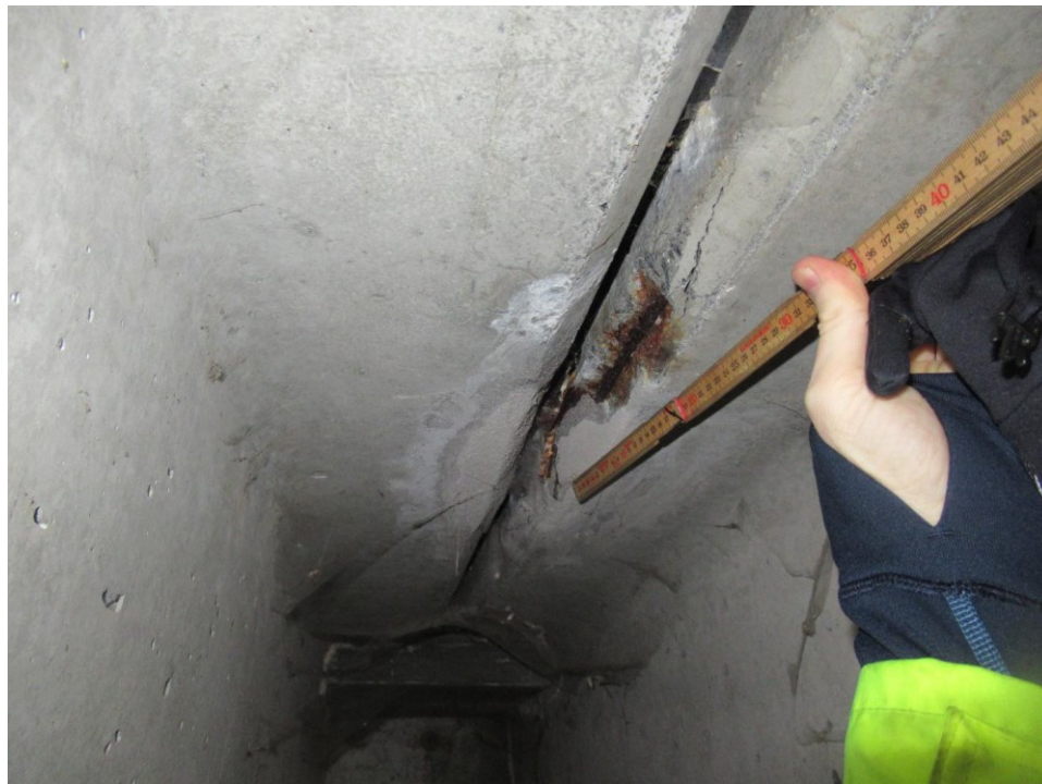
Foto 15: Bærende overbygning: Revne med blotlagt armering ved langsgående elementfuge i nord
