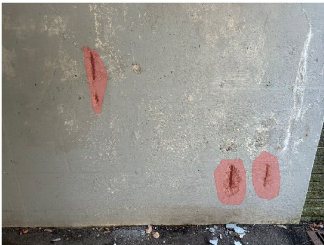
Figur 2 - Dæklagsskader behugges, afrenses og mørtelrepareres
