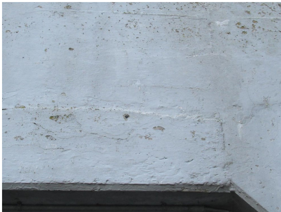
Foto 8: Bærende overbygning: Fine netrevner - enkelte hvide udfældninger
