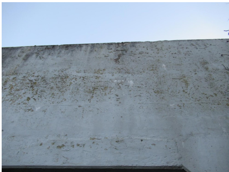
Foto 12: Kantbjælker: Revner med hvide udfældninger
