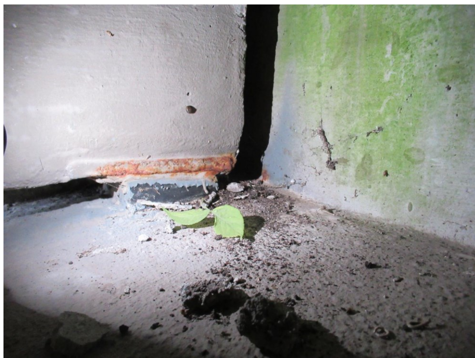
Foto 10: Lejer: Overfladekorrosion på vederlagsplader
