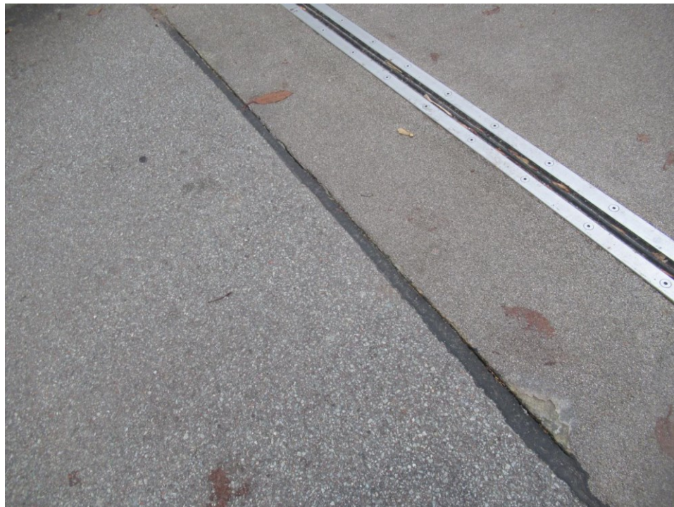
Foto 19: Brobelægninger: Fugeslip i nord
