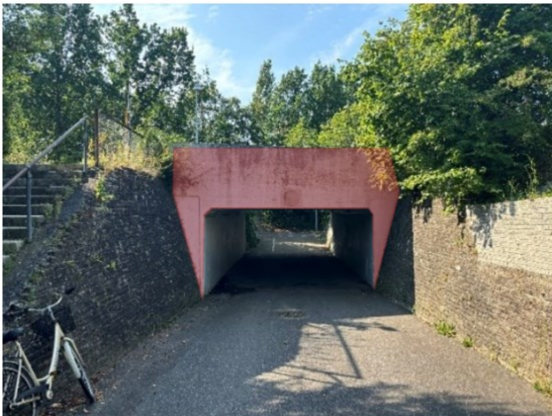
Figur 3 - Afrensning og overfladebehandling af facader og fløje
