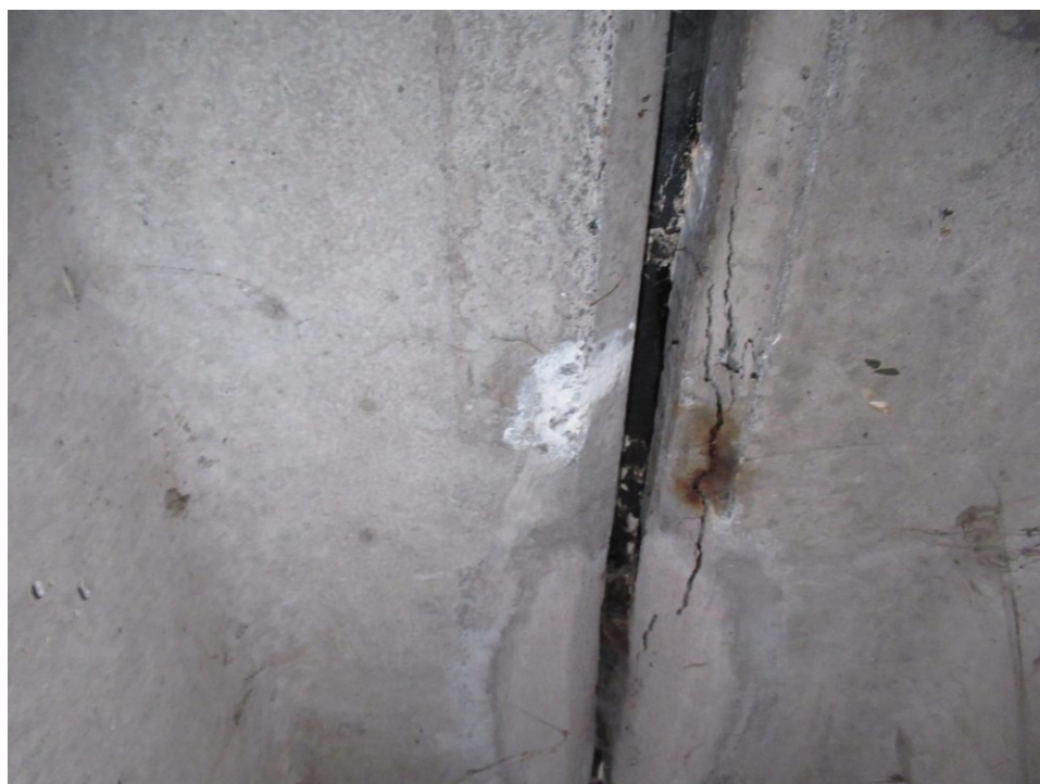
Foto 14: Bærende overbygning: Revne med rustudtræk ved langsgående elementfuge i syd
