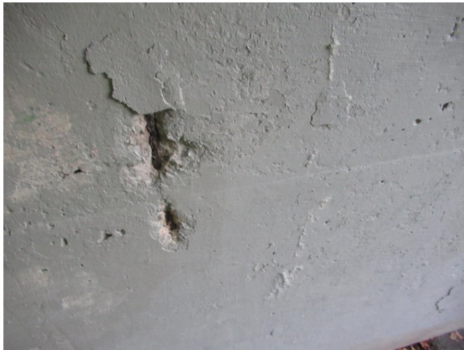
Foto 7: Endeunderstøtninger: Dæklagsskade med synlig armering
