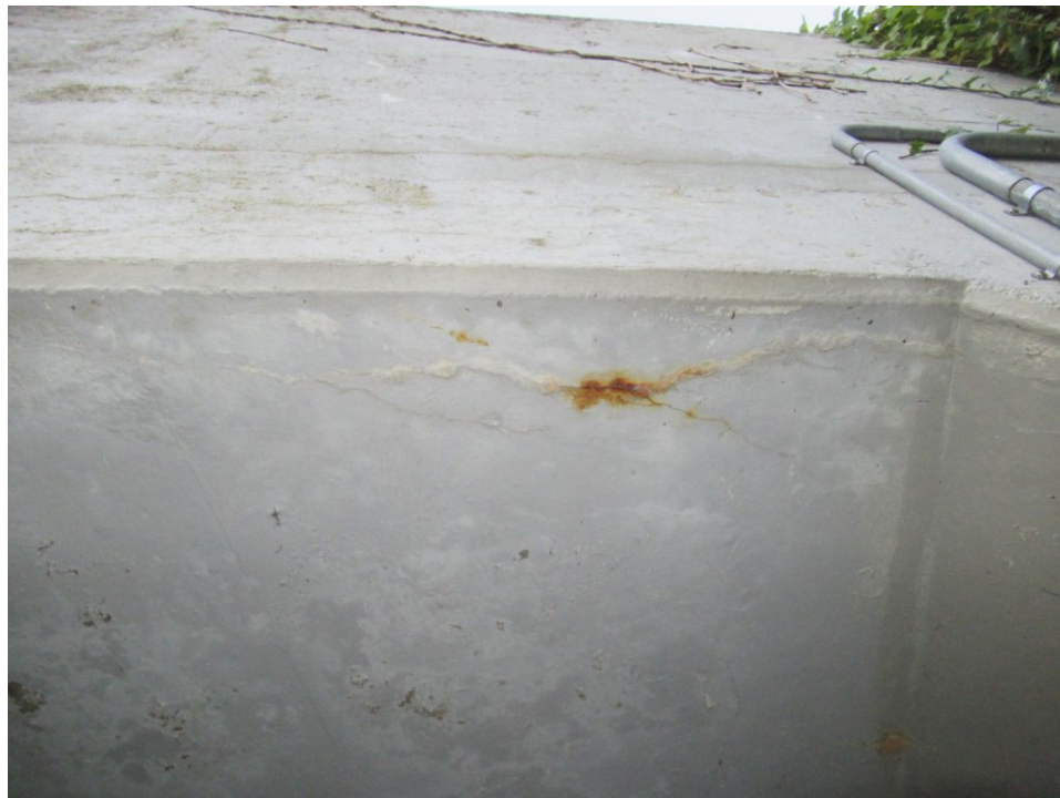
Foto 11: Fugtisolering: Brune/hvide udfældninger under kantbjælke
