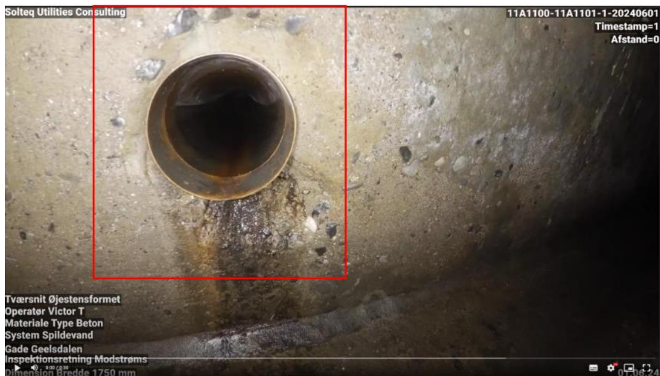
Figur 6. Eksempel på påhug, hvor der er beskadigelser på rørsiden, der skal repareres.
