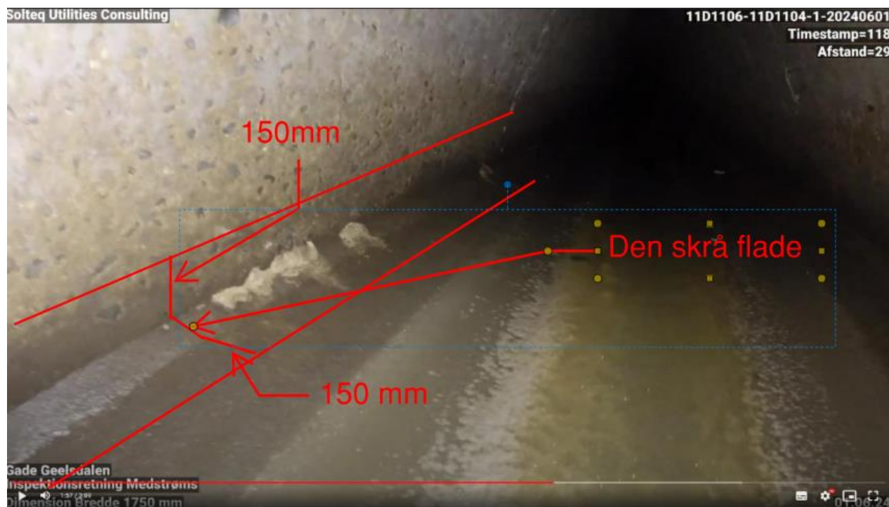
Figur 2. Ledning afrenses til min. ruhed 3 mm i et afskærmet areal, der dækker "hjørnet" mellem bundrenden og overbygningen på kloakledningen. Ca. udbredelse er vist på foto.
