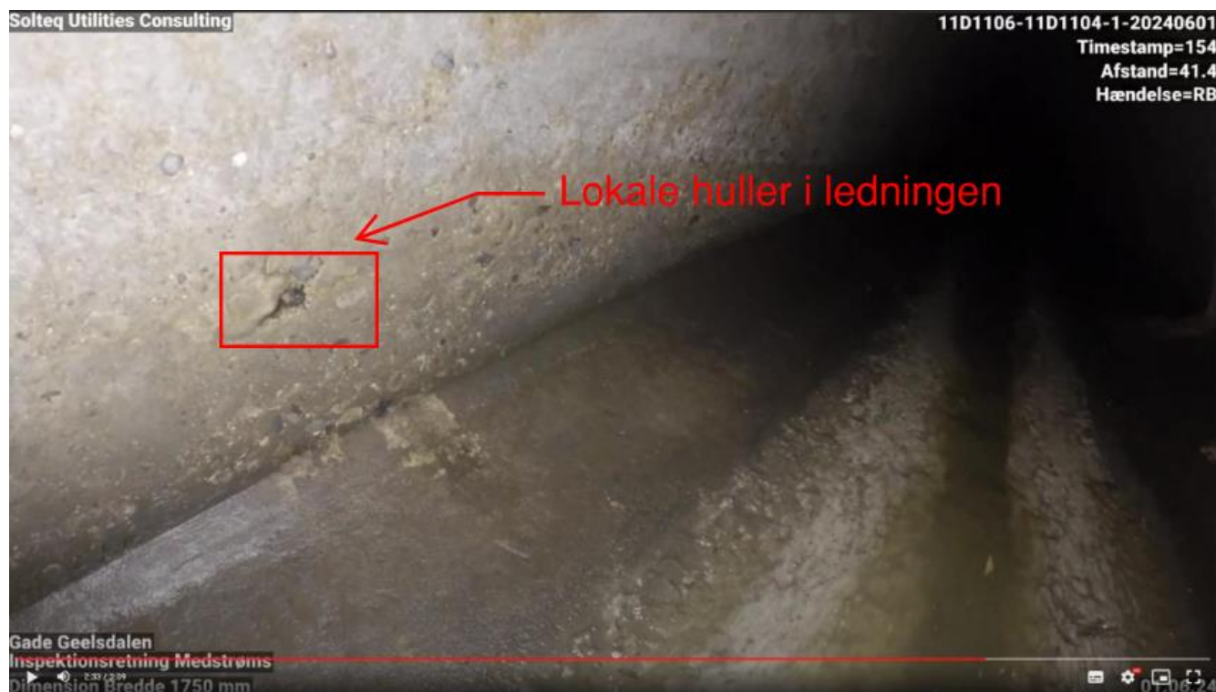
Figur 5. Eksempel på hul i væggen, der skal afrensnes og lukkes.
